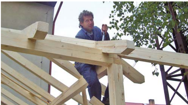
Milan Kopecký při stavbě přístřešku za požární stanicí.
